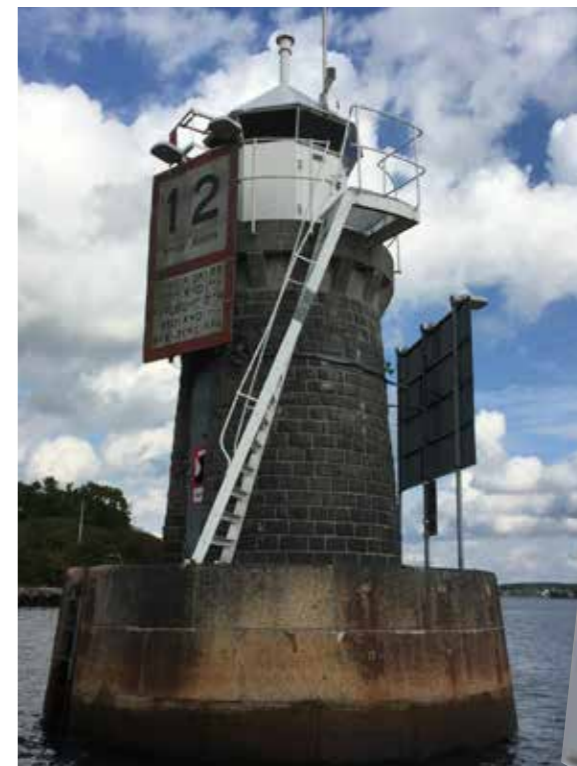
Blockhusuddens fyr (till höger) i Stockholm var Sveriges första fyr som utrustades med en solventil (till vänster). Det var en sinnrik konstruktion som gjorde att gasluset släcktes när det blev ljus och tändes vid mörkrets inbrott. Fyren fick solventilen installerad 1912 och var en viktig orsak till att Gustaf Dahléen tilldelades Nobelpriset i fysik.
